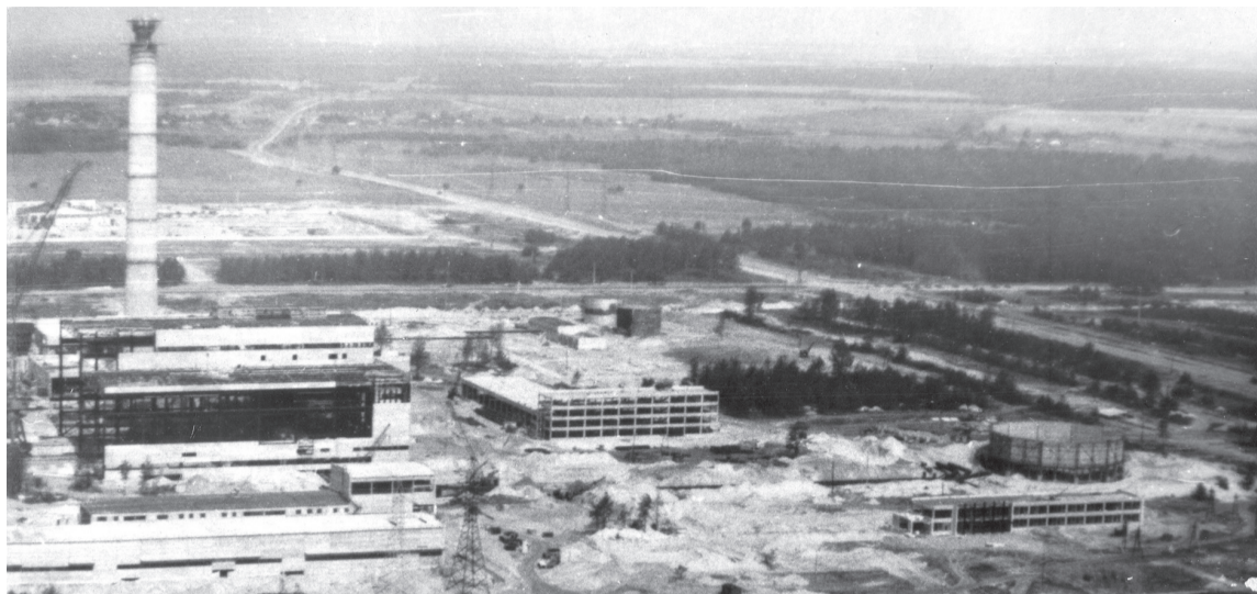
Панорама строительства ТЭЦ, 1973 г.
