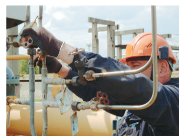
Текущий ремонт ГРП
